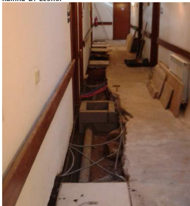
Obras de Requalificação da Ala Norte do Edifício do Lar de Idosos
